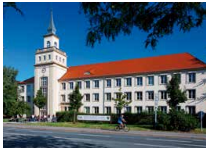
... und das Gebäude heute, mehr als dreitausend Studenten haben hier in den letzten 25 Jahren ihren Abschluss gemacht
