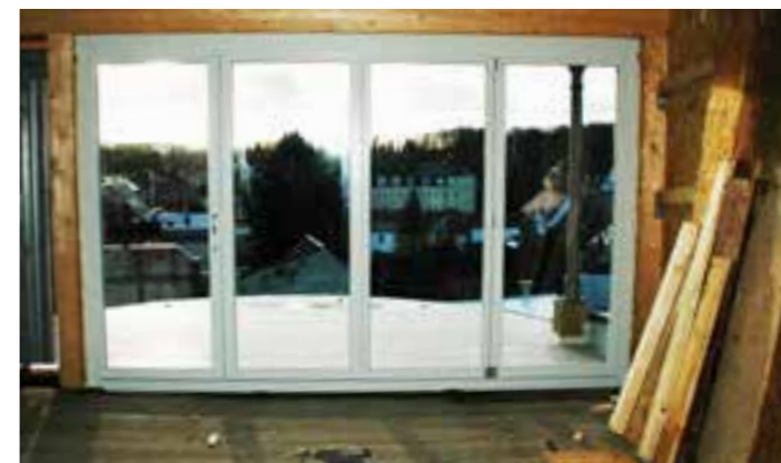
Derzeit noch Baustelle, ab Mitte 2017 das Highlight im Dachloft: die Terrasse mit Blick über Bischofswerdas Dächer
