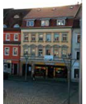
Es tut sich schon was am Bischofswerdaer Altmarkt, die Fassade ist bereits fertig und der Innenausbau im vollem Gange.
